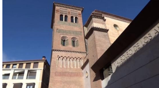
Torre de la iglesia de san Pedro.
