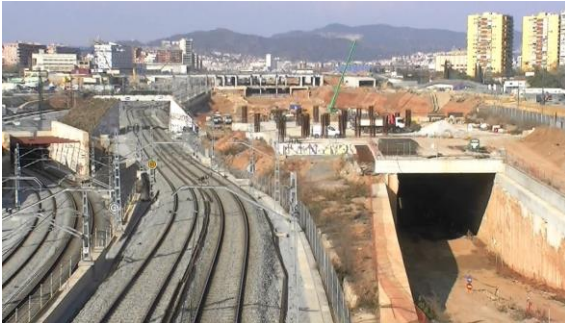
Construcción de estación de tren en Barcelona.
